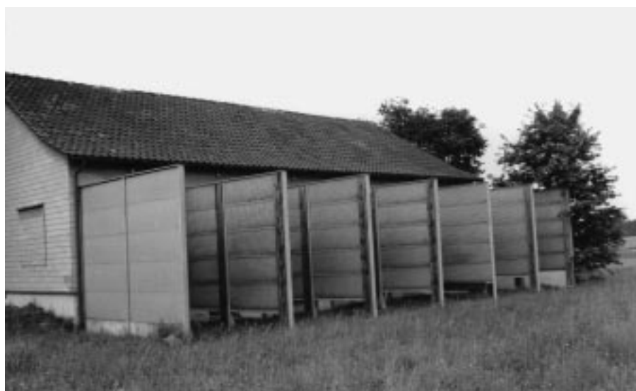
Abb. 4: Seitenblenden zur Reduktion des Mündungsknalls
