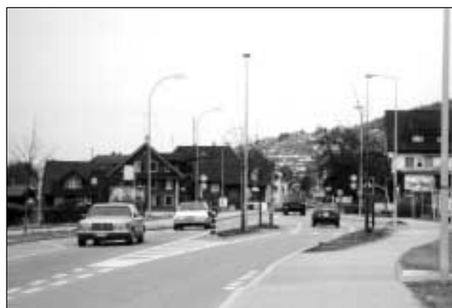
*Fig. 2: Nouvel aménagement de l'espace routier à l'entrée de la localité de Root (LU). Des îlots placés au milieu de la chaussée font ralentir les automobilistes, qui adaptent ainsi leur vitesse avant même d'entrer dans le village.*
